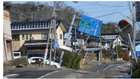
液状化（内灘町西荒屋地内）
