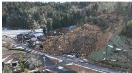
山腹崩壊（珠州市正院町地内）
