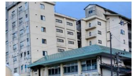
建物損壊（和倉温泉（七尾市））
