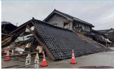
家屋倒壊（珠州市三崎町地内）
